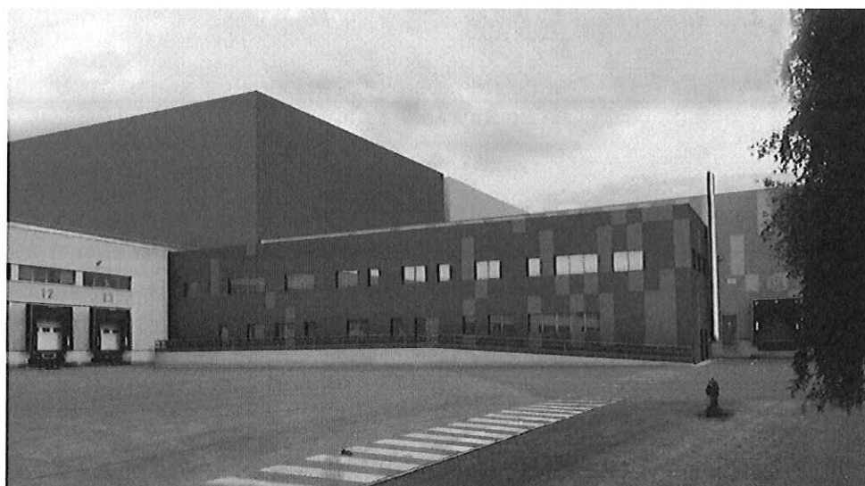
Figure 10 : vue d'ensemble du futur bloc et des palettiers à l'arrière-plan
